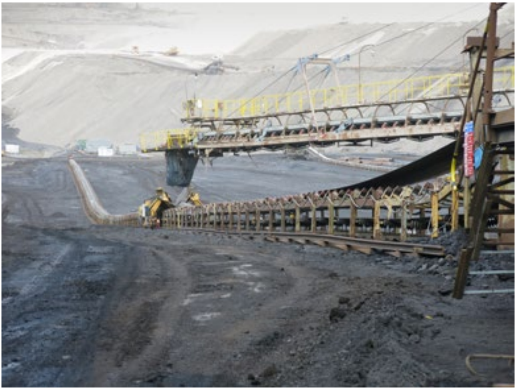
Dopravník, Důl Bílina / Conveyor belt, Bílina mine, photo: Robert Vlasák
