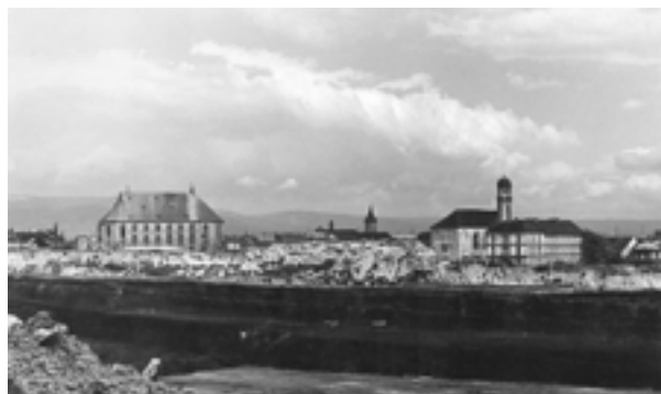
Most, likvidované město, 1978, fotoarchiv Oblastní muzeum Most / Demolition of Most, 1978, photo archive, Most District Museum
