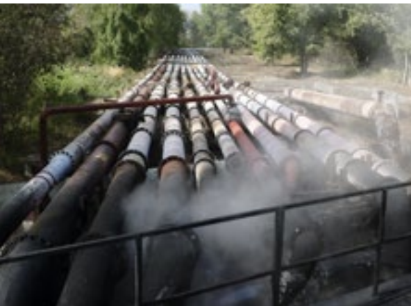
Záluží industrial park, foto Peter Cusack
